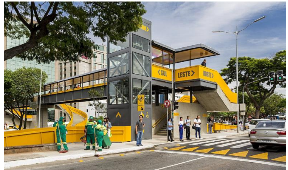
Passarela como solução para rodovias
